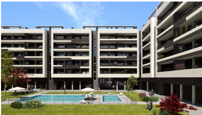
El Residencial Vía Verde, una promoción de obra nueva en obras, dispondrá de viviendas Passivhaus. | GRUPO LOBE
