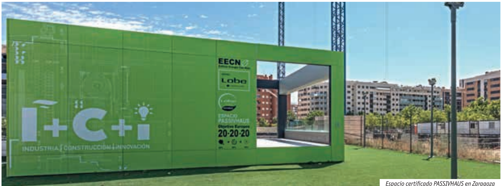
Espacio certificado PASSIVHAUS en Zaragoza
