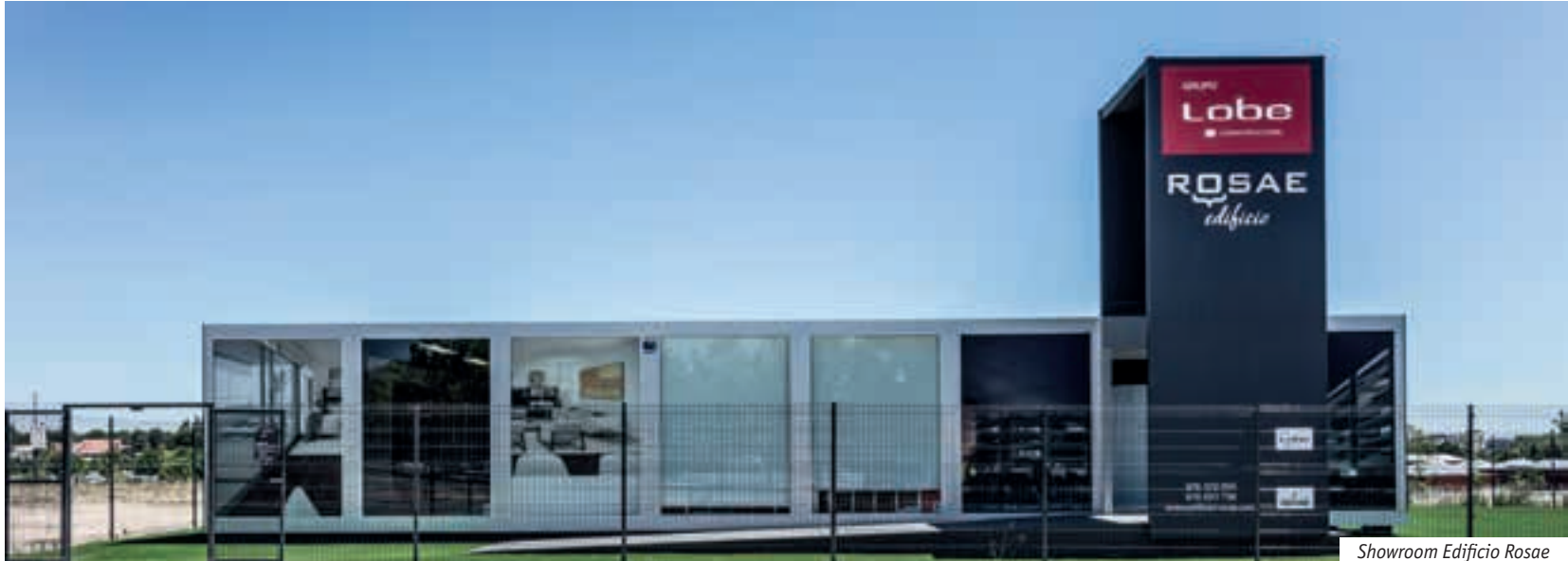
Showroom Edificio Rosae
